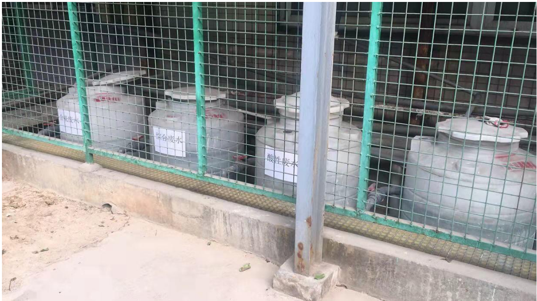
图 7.1-2 废水分类收集罐照片
